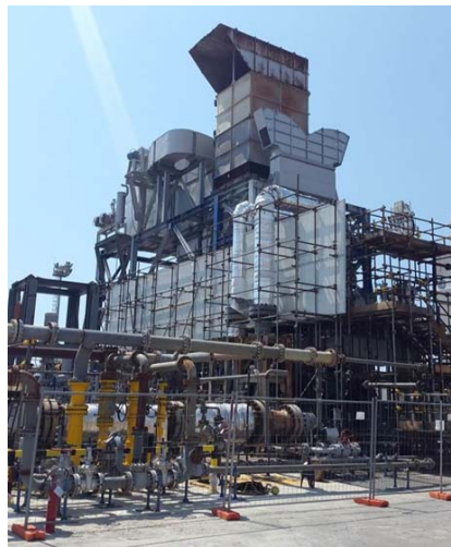
Figura 1 – Alcune immagini di allestimento per uno String Test
